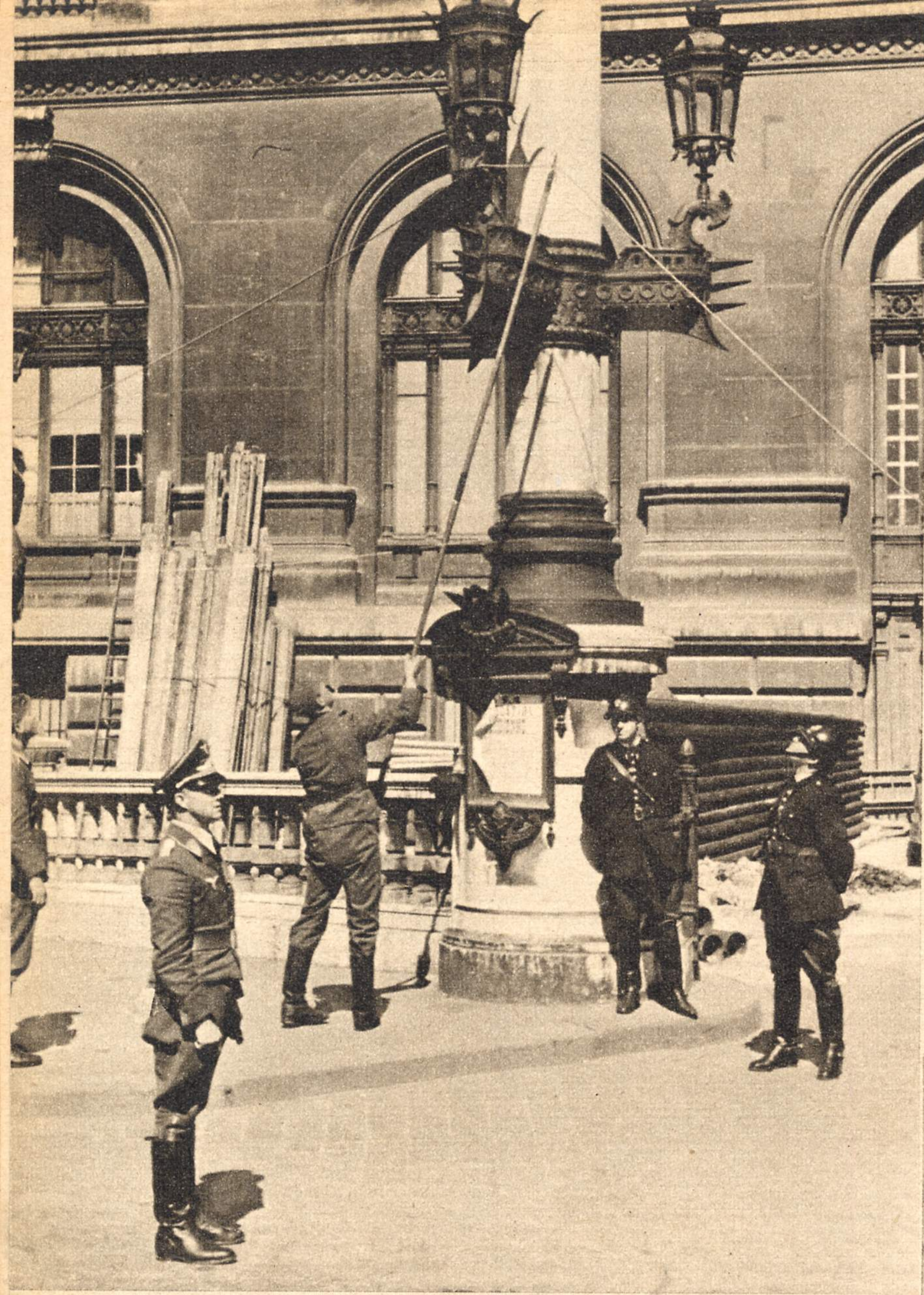
Die vielfach verschnörkelten Laternenträger in Paris, hier insbesondere die Bugspitzen römischer Galeeren, eignen sich vorzüglich zur Aufnahme von Kabelleitungen
