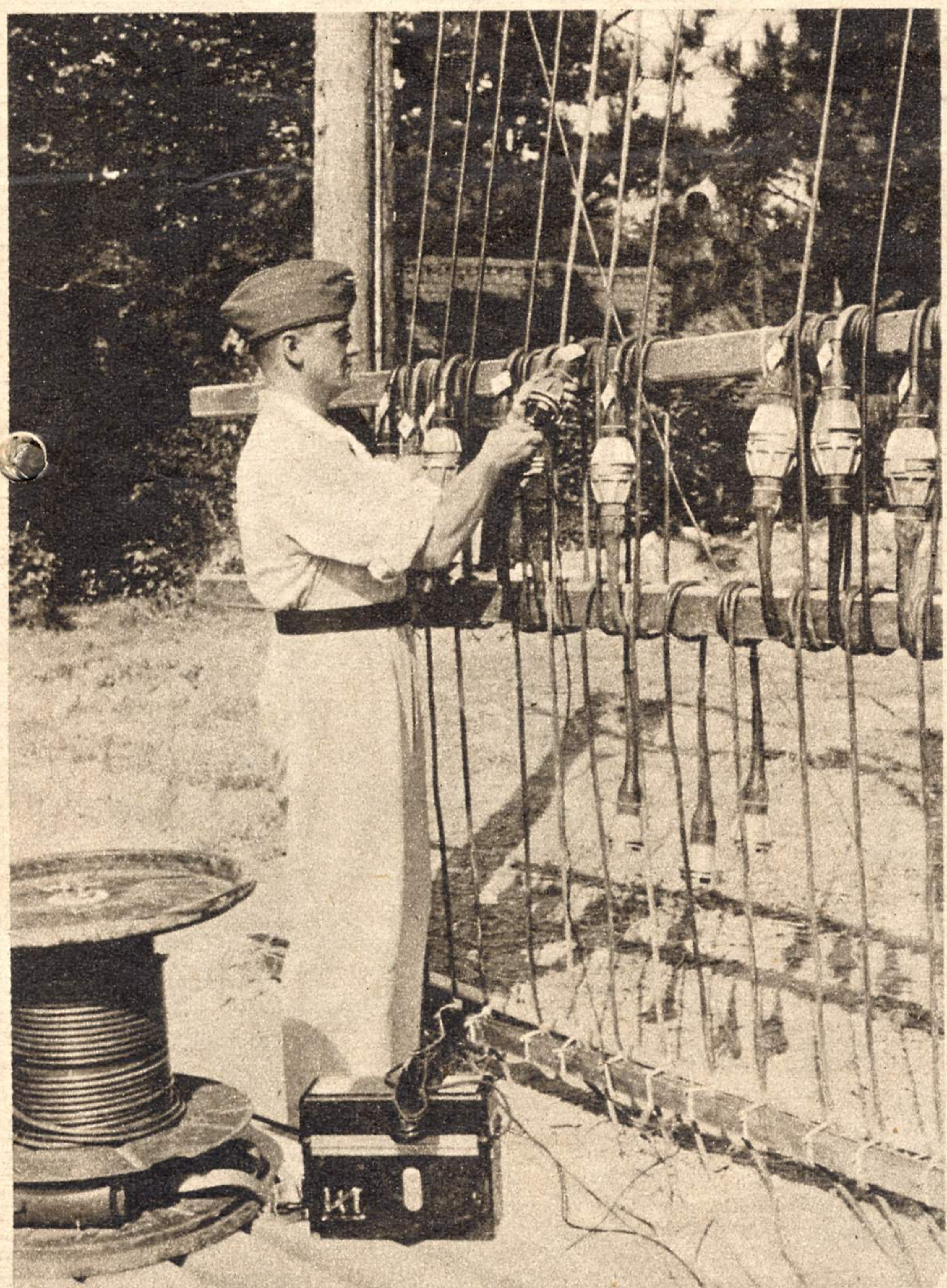
So sieht eine Anschlußstelle aus, an der mehrere Feldkabel zusammenlaufen. Ein Fernsprengerät steht bereit, mit dem der Funker sich bei etwaigen Störungen in jede Leitung einschalten kann. Die einzelnen Leitungen sind durch kleine Täfelchen gezeichnet. Neben dem Funker eine schwere Kabelrolle
